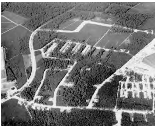
Fortschritt der ersten beiden Bauphasen im Sommer 1958
