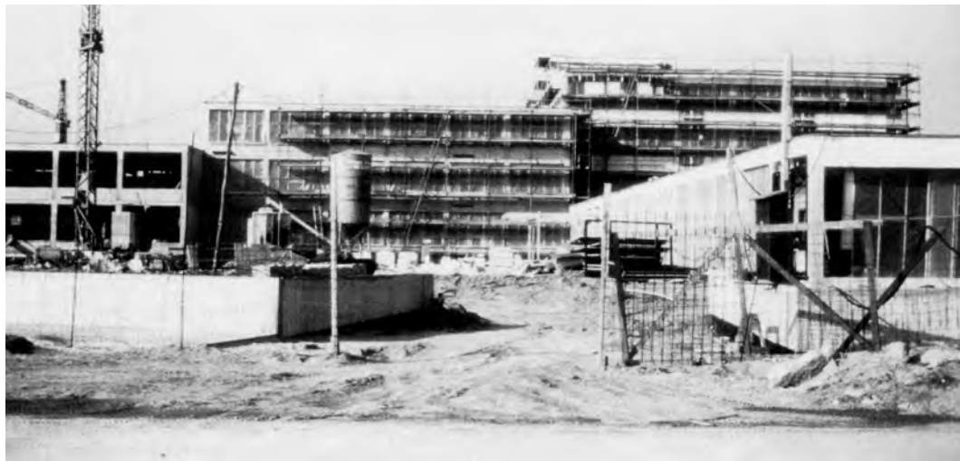
Das Otto-Hahn-Gymnasium im Bau (Stand 1972)
