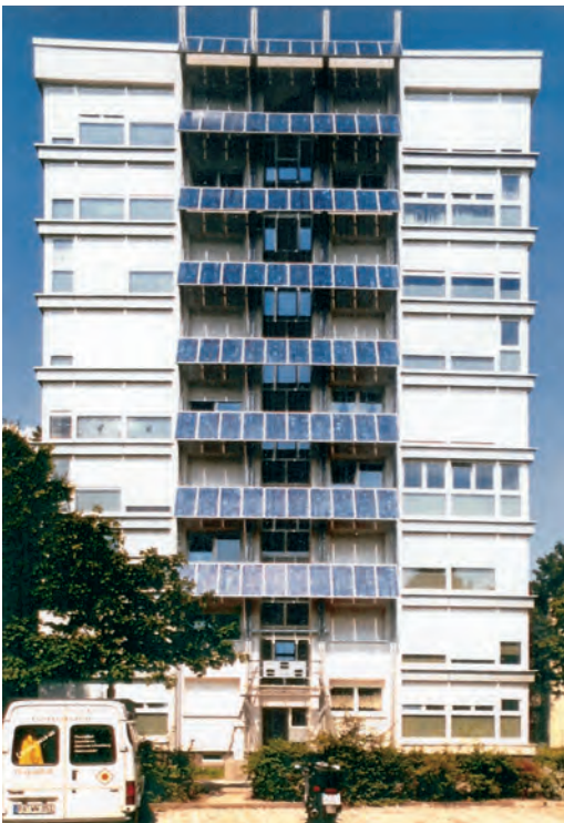
Wohngebäude der Volkswohnung in der Kolberger Straße 23 nach der Sanierung
