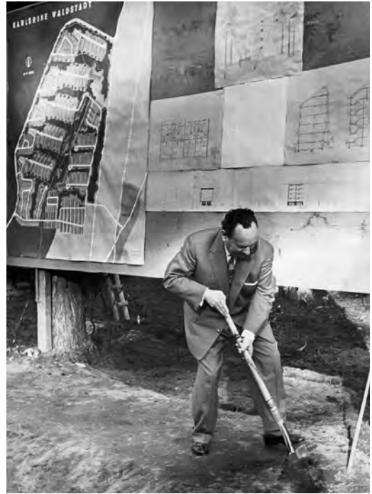
OB Günther Klotz beim ersten Spatenstich
