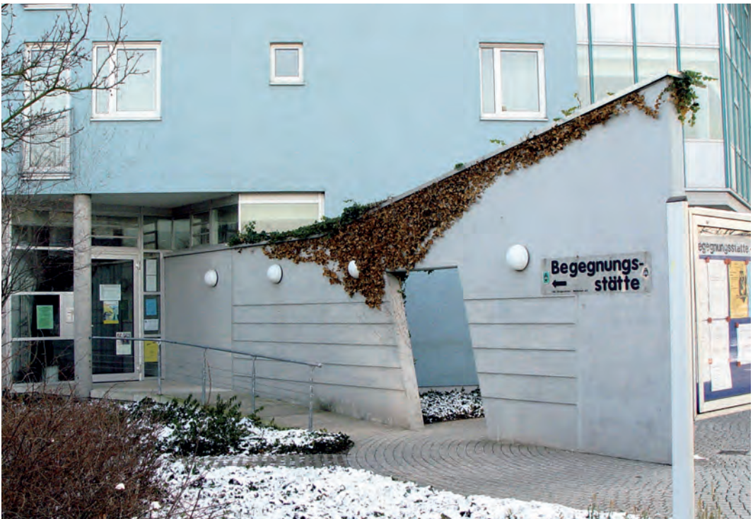
Der Eingangsbereich der Begegnungsstätte
