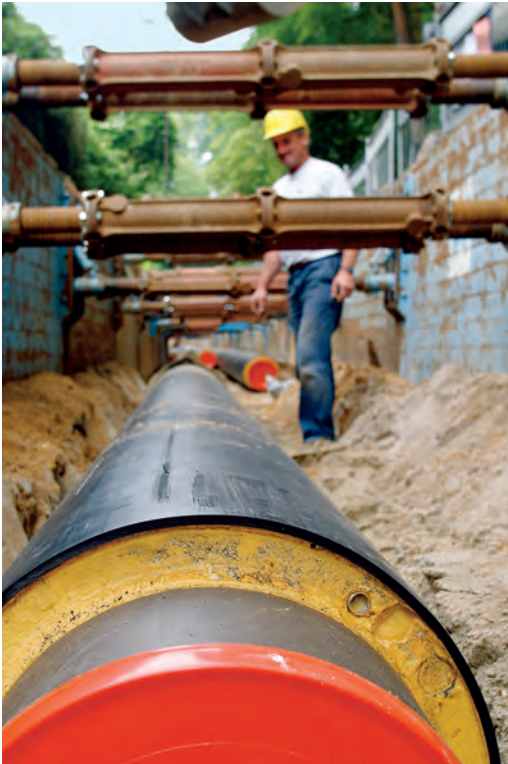
Die Fernwärmerohrleitungen werden in ca. 2 m Tiefe im Erdreich verlegt. Die Stahlrohre haben einen Innendurchmesser von 30-40 cm. Sie sind umkleidet von einer dicken Isolationsschicht und durch ein äußeres Kunststoffrohr.
