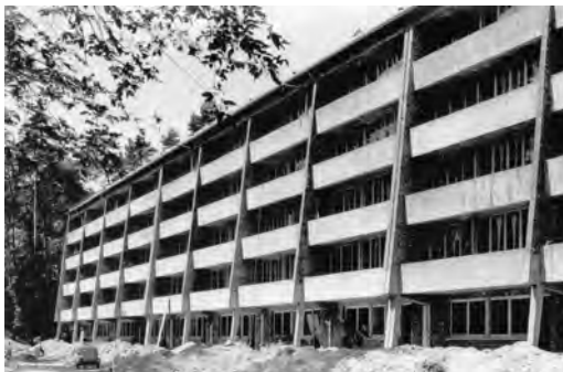
Ostseite eines Schrägfassadenwohnblocks während der Bauphase
